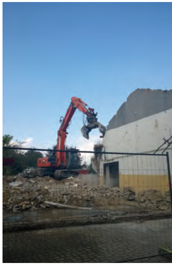
Abrissarbeiten am wohl bekanntesten Raum, dem Hörsaal 2000
